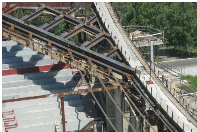
Рис. 4. а) Смонтированный опорный контур на временных опорах б) Начало навески нитей «постели».
