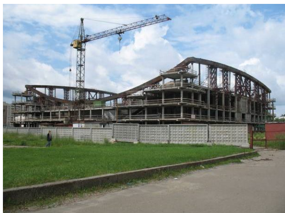
Рис. 4. а) Смонтированный опорный контур на временных опорах б) Начало навески нитей «постели».
